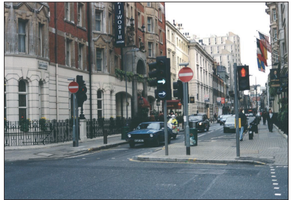
הצרת רוחב הכביש בצומת ע"י "אוזן", לשם הרחבת המדרכה והקלת חציית הולכי הרגל
